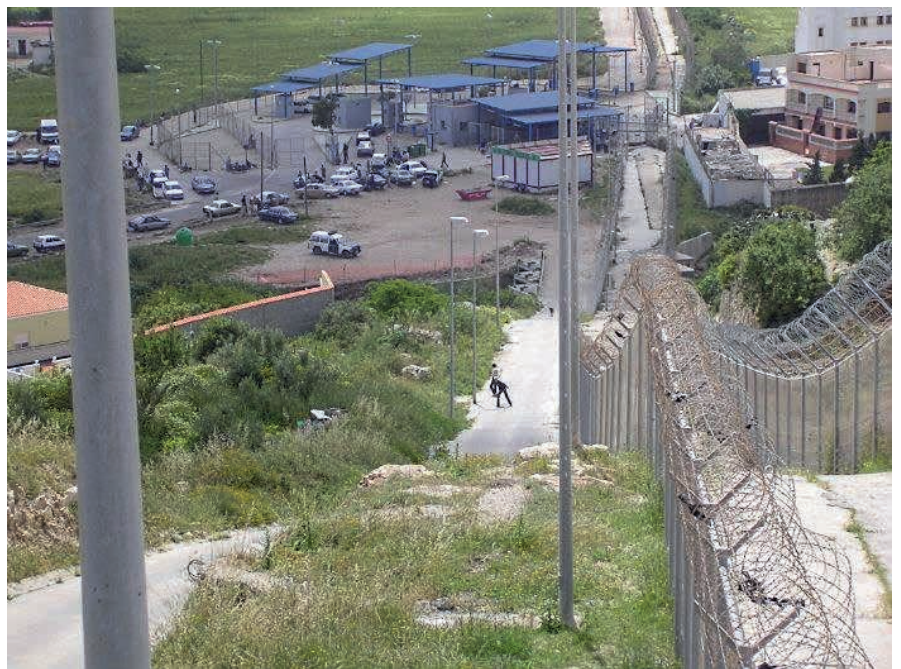
Grenzanlage von Mellila
