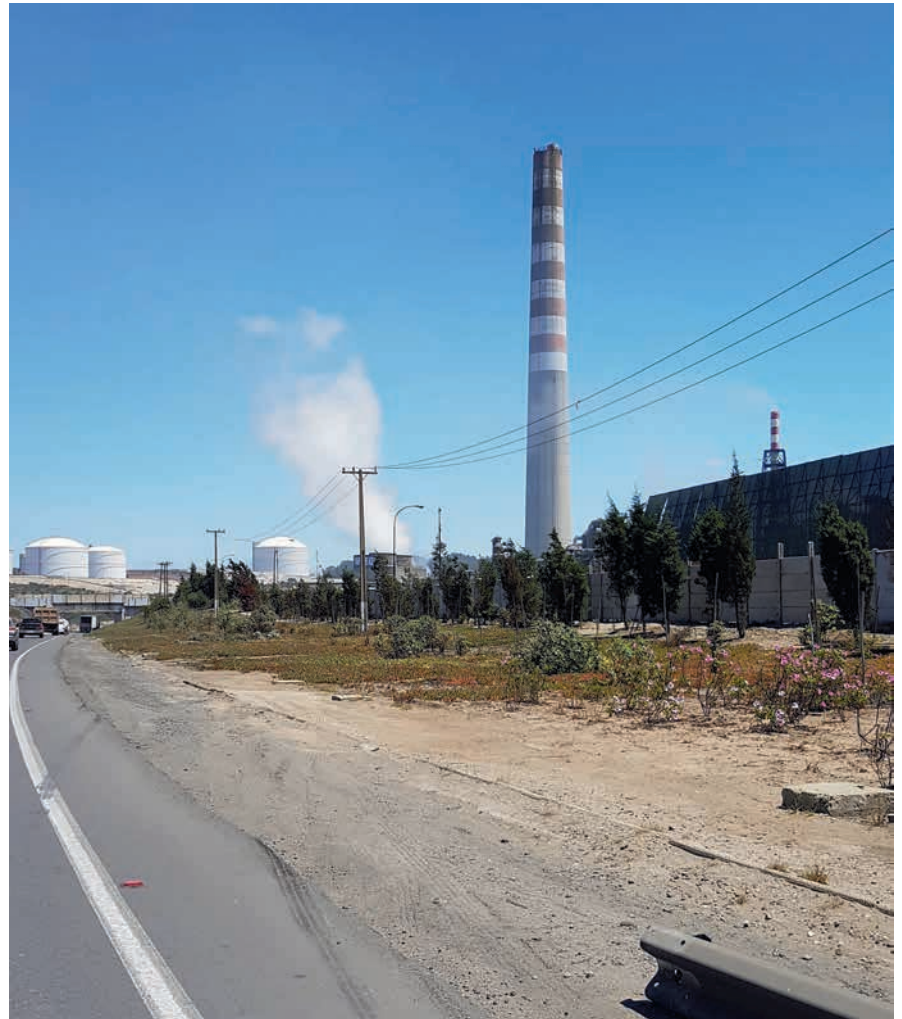
Raffinerie und Schmelzbetrieb in Las Ventana
